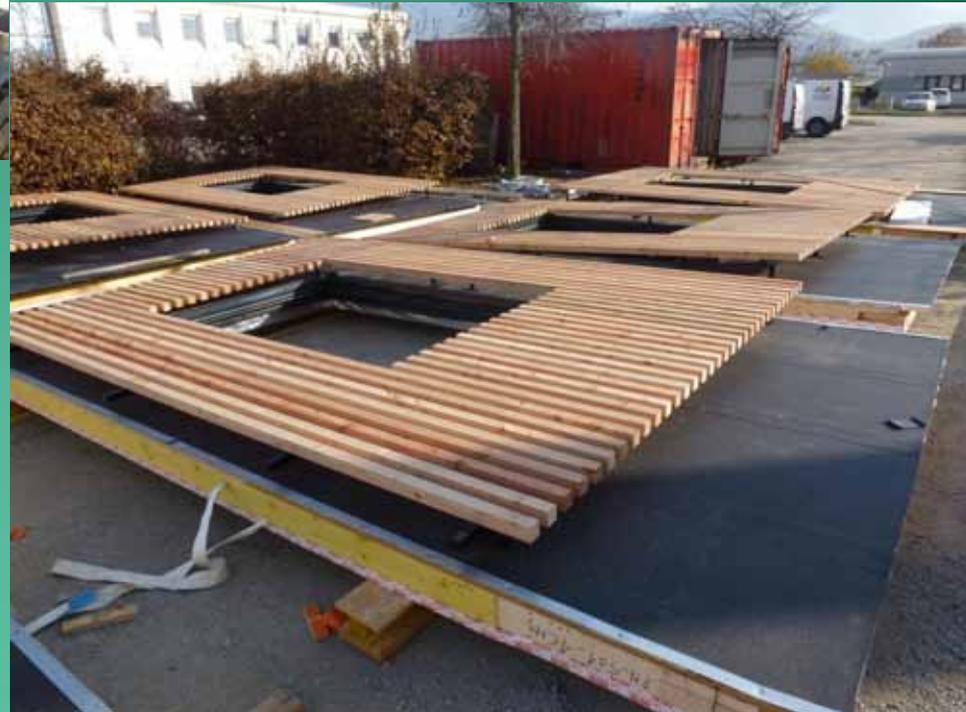
ASSEMBLAGE SUR LE SITE : Des panneaux façade et de la grille bois en vêtue. ( avec effets d'écailles )
