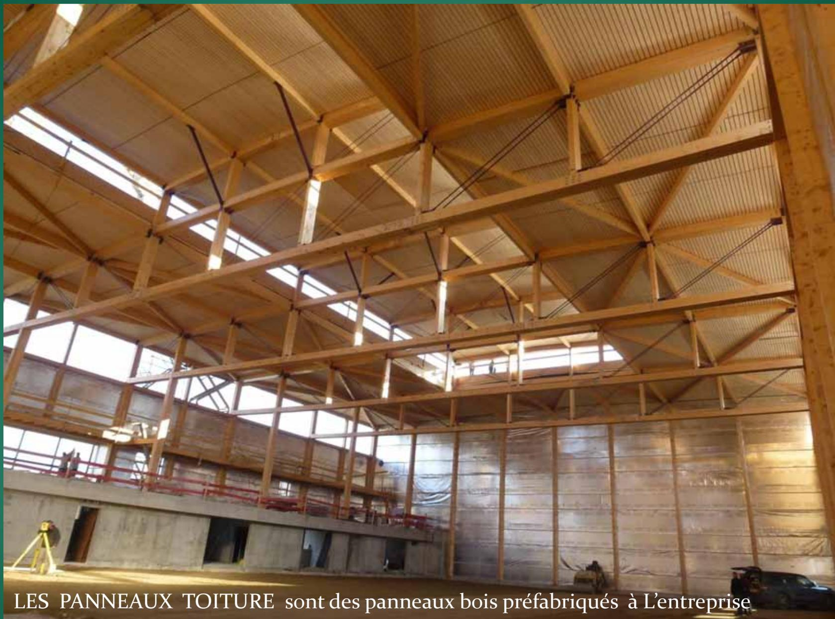
LES PANNEAUX TOITURE sont des panneaux bois préfabriqués à L'entreprise
